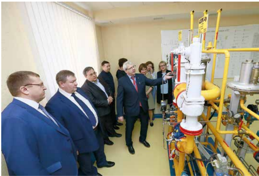
Олег Смирнов рассказывает о принципах работы газораспределительной станции
