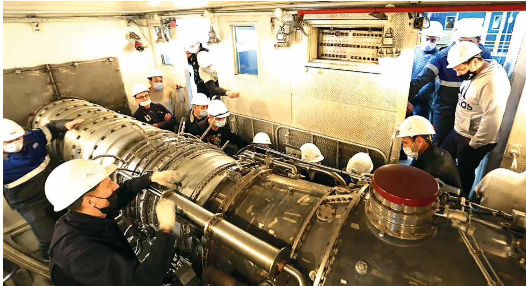
Практический этап состоялся на КС-4 «Поляна»
