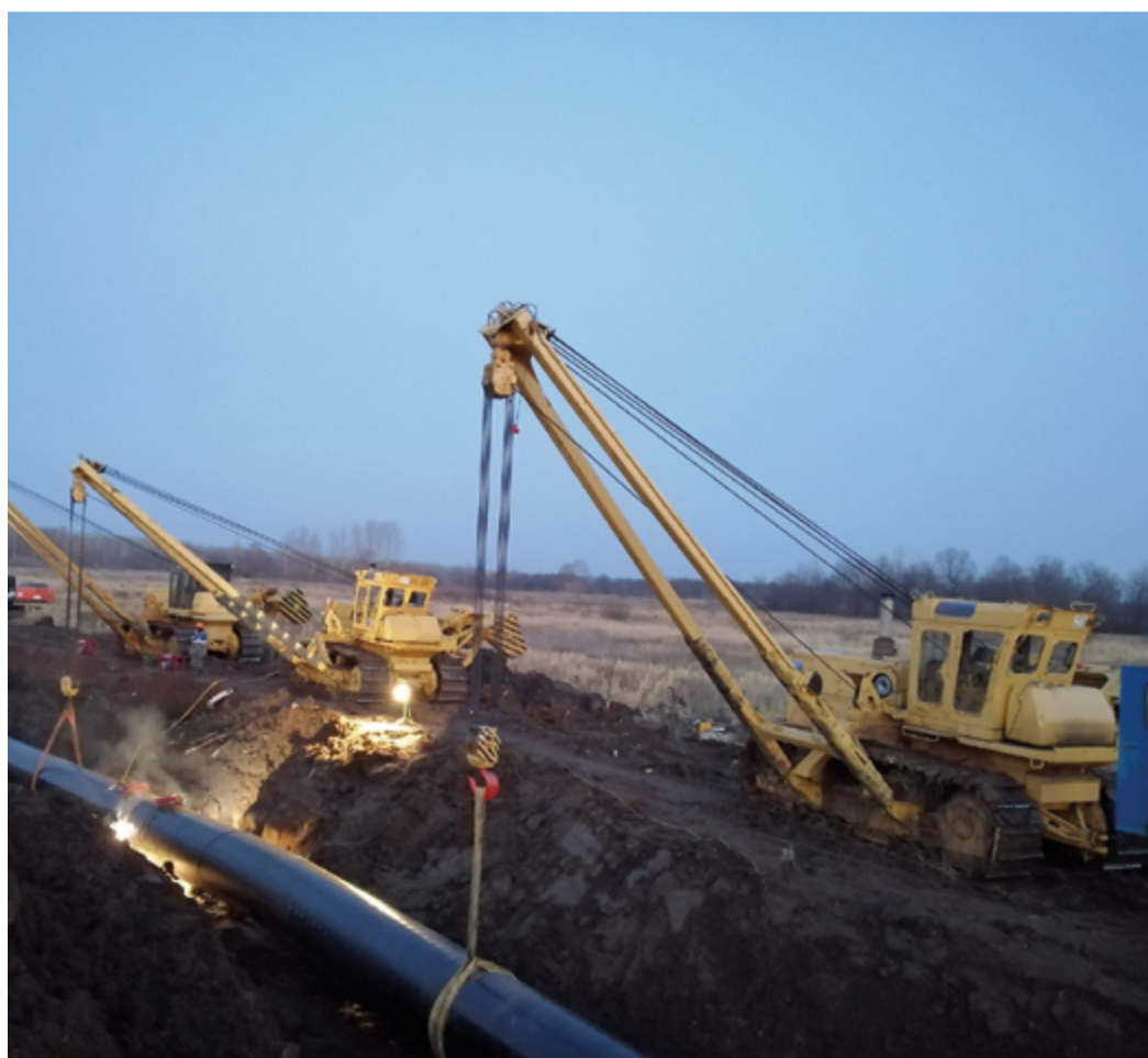
Устранение дефектов резервной нитки МГ Уренгой–Петровск
