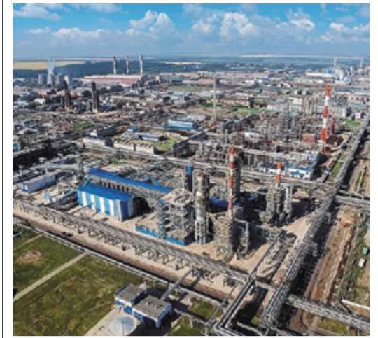
Промплощадка ООО «Газпром нефтехим Салават»
