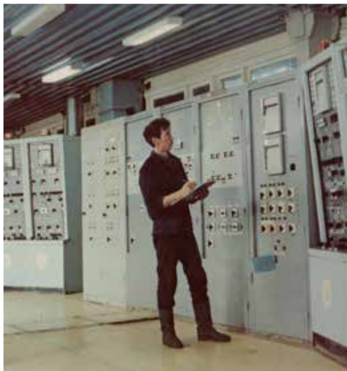
КС-18 до реконструкции
