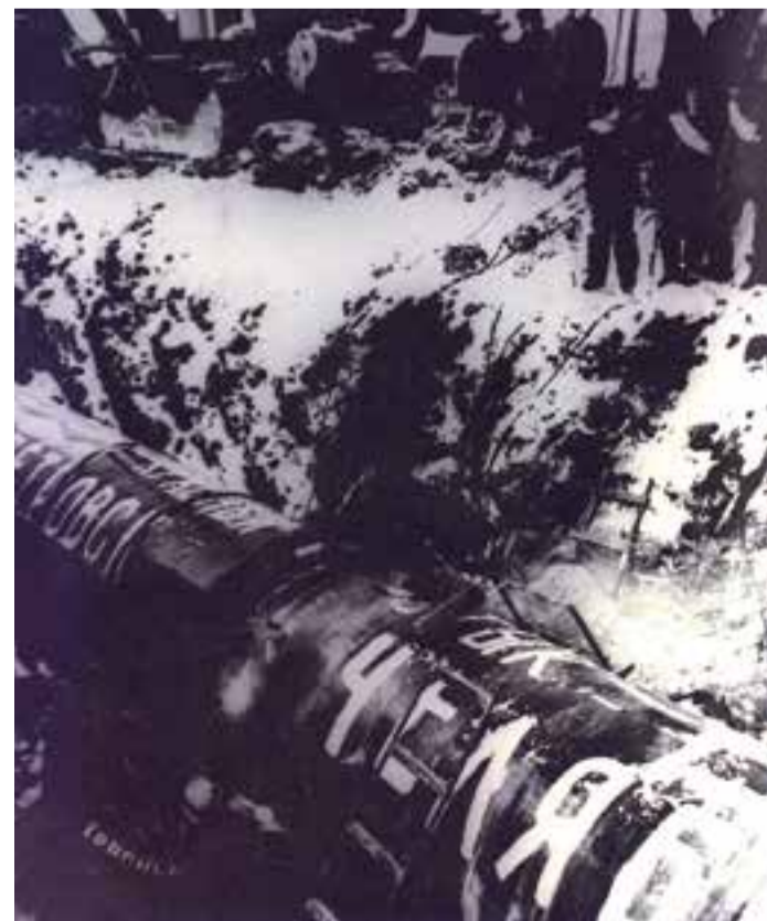
Сварка «красного стыка», 1979 год
