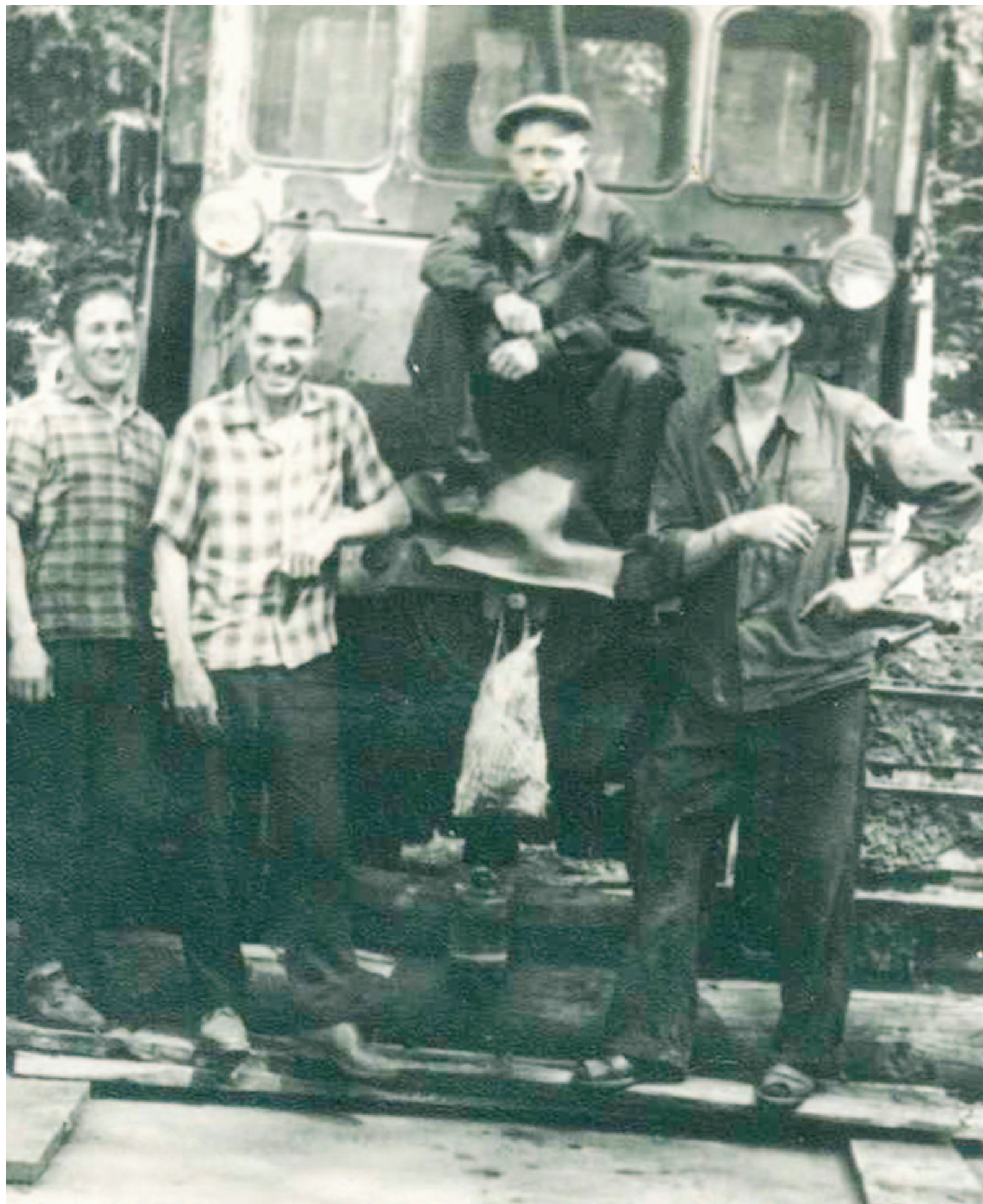
Газовики-первопроходцы на строительстве газопровода Туймазы–Уфа–Черниковск (фото из архива Виктора Крайнева)
