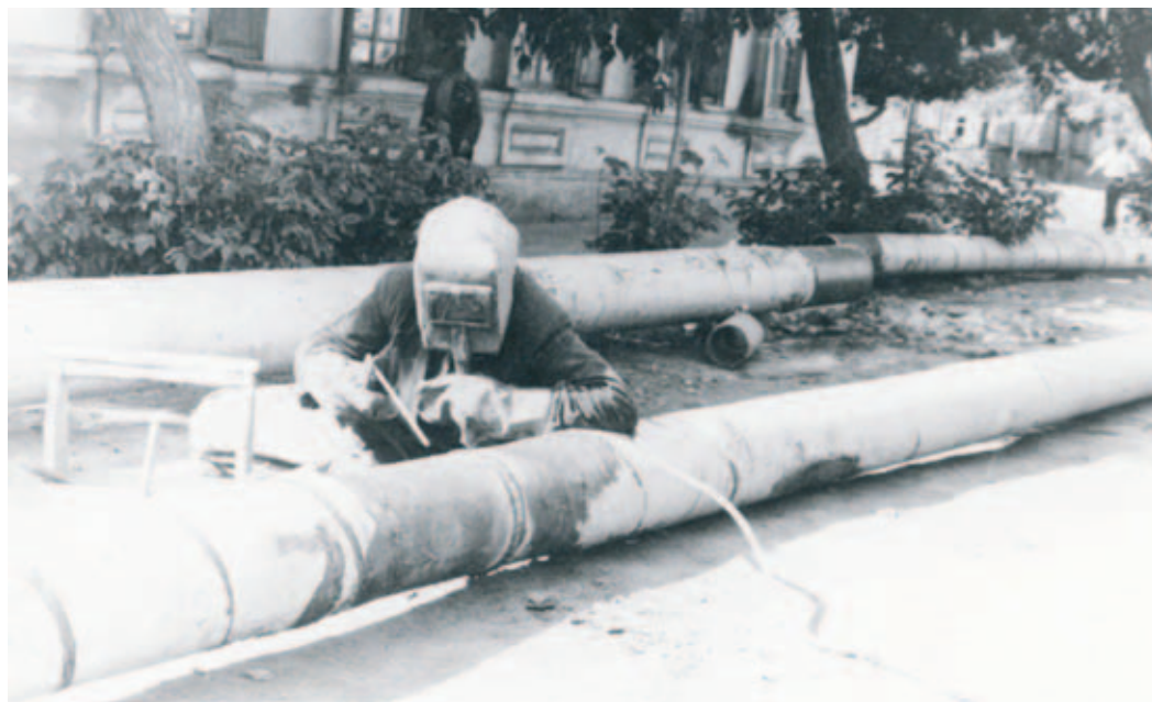
Сварка газопровода на улице Чернышевского в Уфе. 1953 г. (фото из архива ССОиСМИ)
