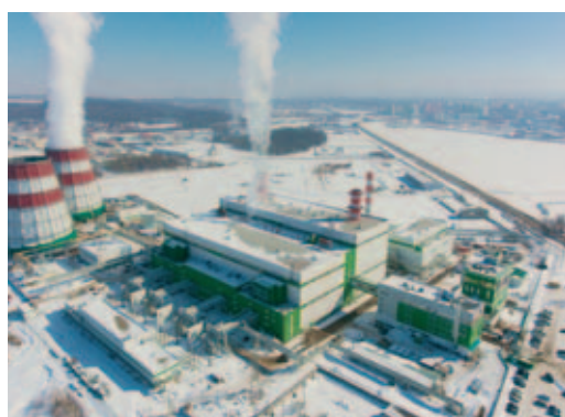
С вводом Затонской ТЭЦ республика становится самодостаточной с точки зрения выработки электроэнергии (фото пресс-службы Главы РБ)
