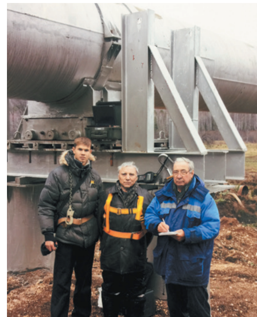
Леонид Быков с коллегами во время обследования воздушного перехода магистрального газопровода Челябинск–Петровск через реку Юрюзань, 2012 год (фото из личного архива Леонида Быкова)
