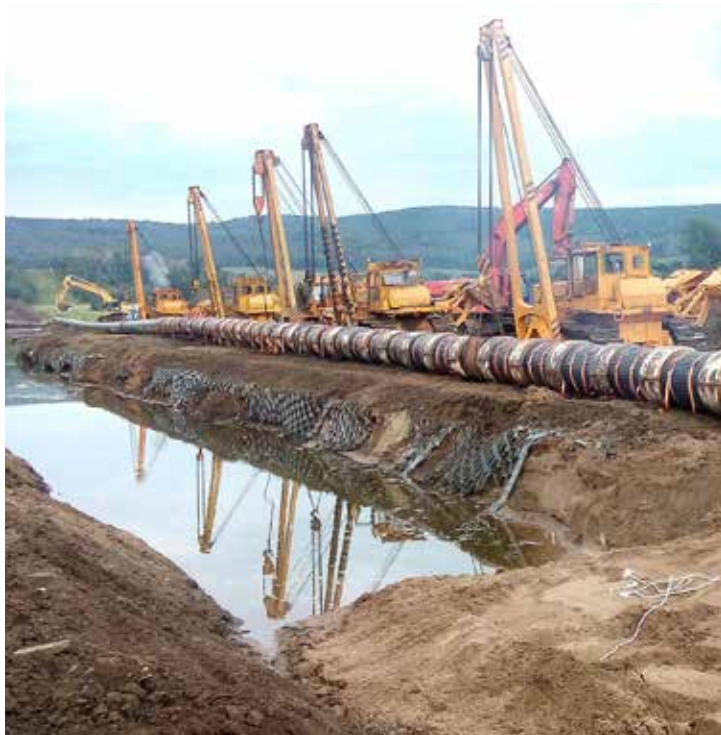
Подводный переход через горную реку Ай
