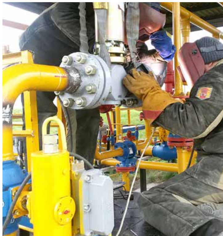
Работы на ГРС «Большеустьикинское» Аркауловского ЛПУМГ
