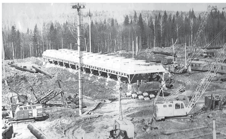
Строительство КС «Полянская»
