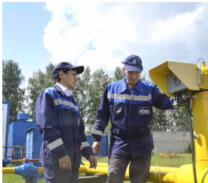
ГРС Краснохолмский – полигон для испытаний «Вымпела»
