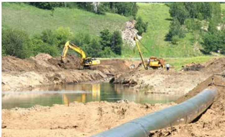
Работы идут полным ходом
