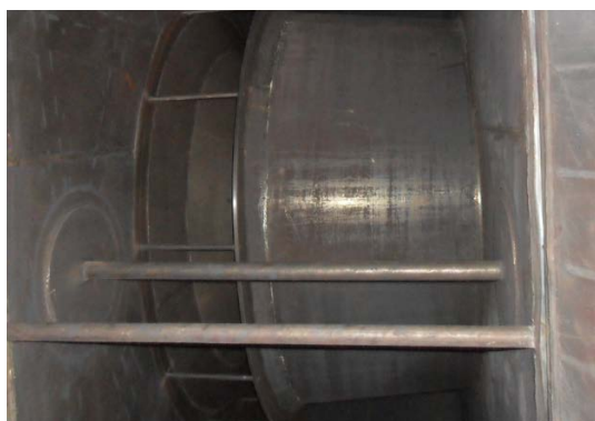
Конструкция диффузора в газоотводе ГПА до...
